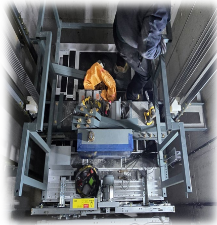
승강로 케이블 결선 작업
