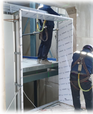
삼방틀 설치 작업
