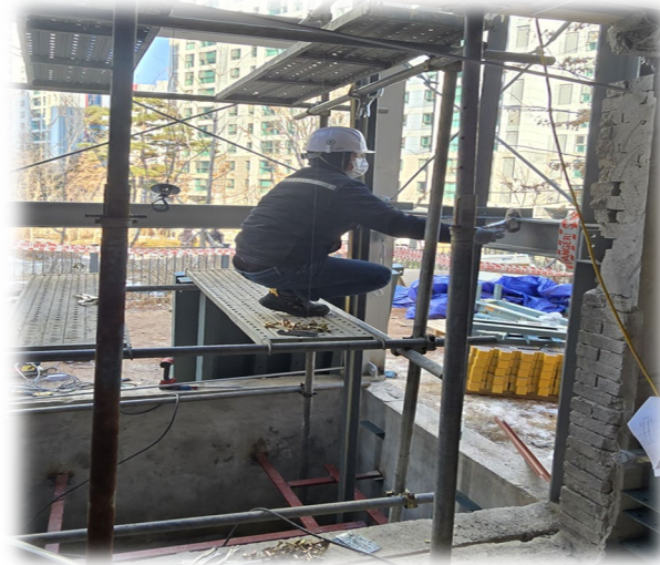
레일 브라켓 수직도 체크
