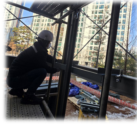
레일 브라켓 고정 작업
