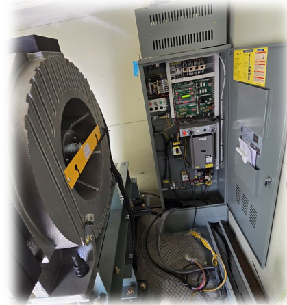
제어반 결선 작업
