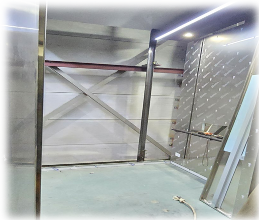
카 판넬 조립 작업
