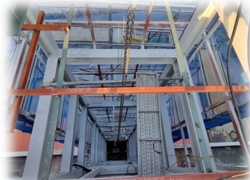
MRL 상부 형판 및 비계 설치
