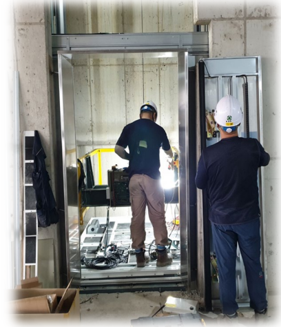
도아 설치 작업
