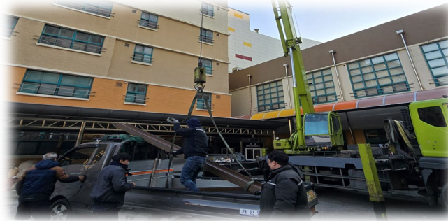
타워 크레인 로프와 자재 결속
